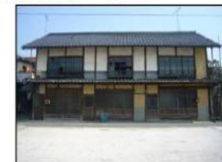
窓が割れ、放置されている空家
