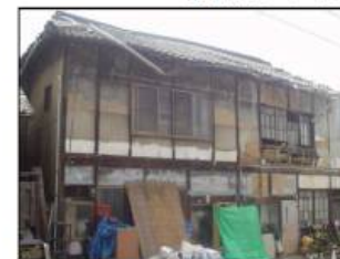
長期間人が住んでいない空家
