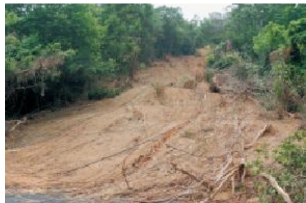
豪雨などの際に、崩壊が起こりやすい
