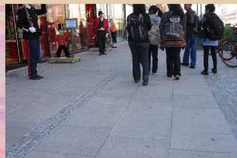
バリアフリー化された歩道
