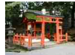
実験で採取した荒皮で屋根葺替工事を予定している春日大社末社 祓戸神社
