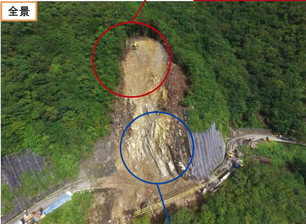
不安定岩塊除去完了状況
