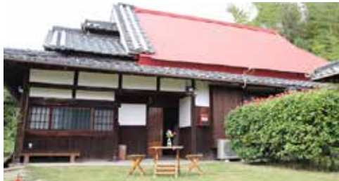
▲日本的传统房屋“大和栋”
