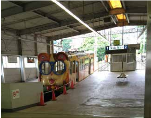
▲生駒ケーブルカーと駅の様子
