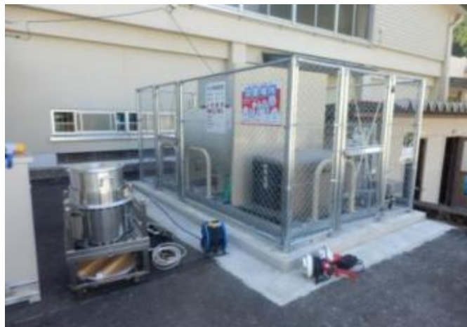
LPガス発電機の整備(十津川村)
