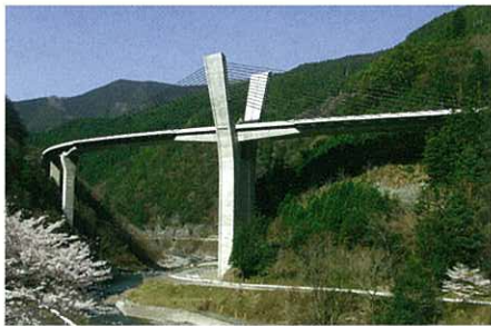
つなどう 辻堂バイパス(奈良県)
