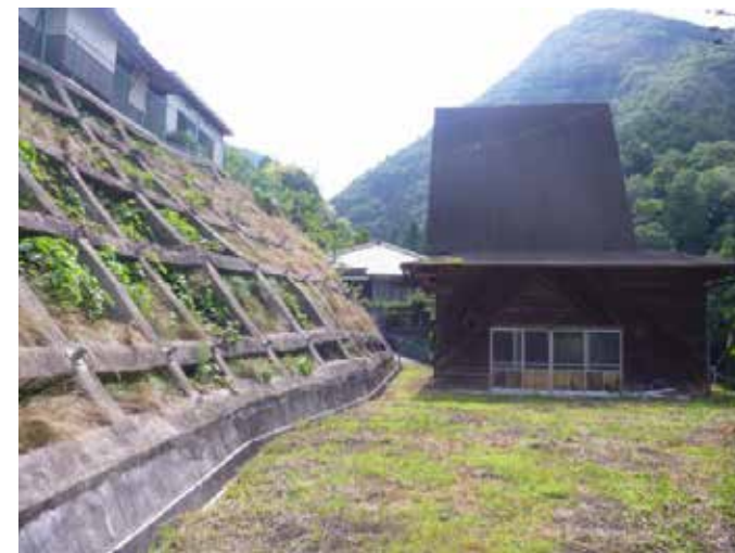
対策済み箇所
