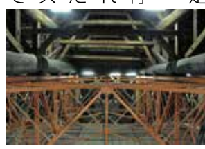
鉄骨トラス(撮影・箱崎和久)
