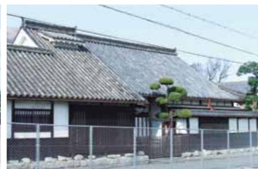
③中村家(国重要文化財) 旧家が多い名柄で最も代表的な建物で、かつて代官屋敷であった中村家。慶長年間(1596~1615)建立。切妻造段違、本瓦葺で、農家に近い町家形式。入口手前には、手押し消火ポンプが吊り下がっている。
