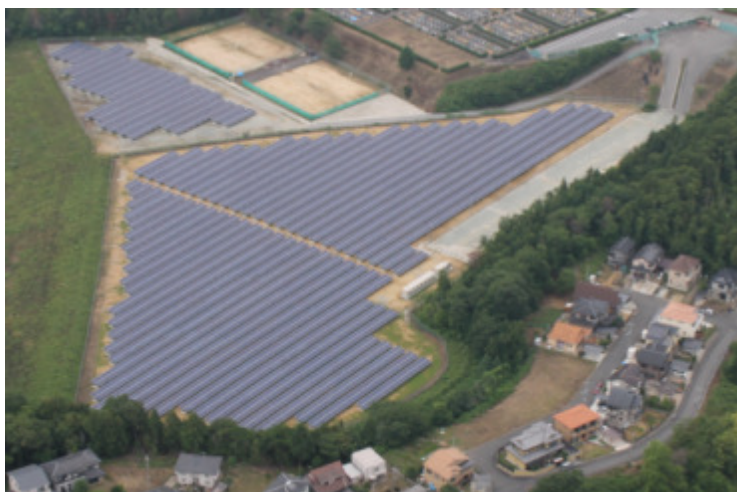
シャープ桧垣本太陽光発電所(大淀町)
