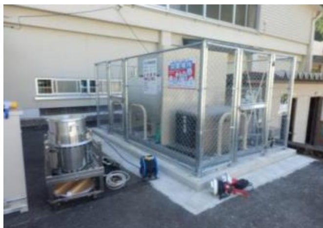
LPガス発電機の整備(十津川村)
