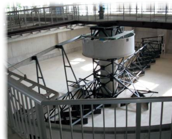
老朽化した下水道施設の更新
