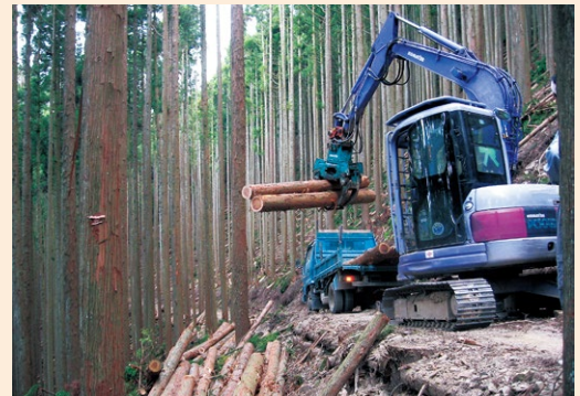
奈良型作業道を利用した出材
