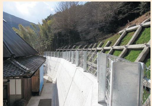
急傾斜対策工事 (東吉野村)
