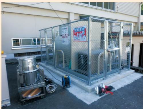
LPガスバルク発電設備（十津川高校）
