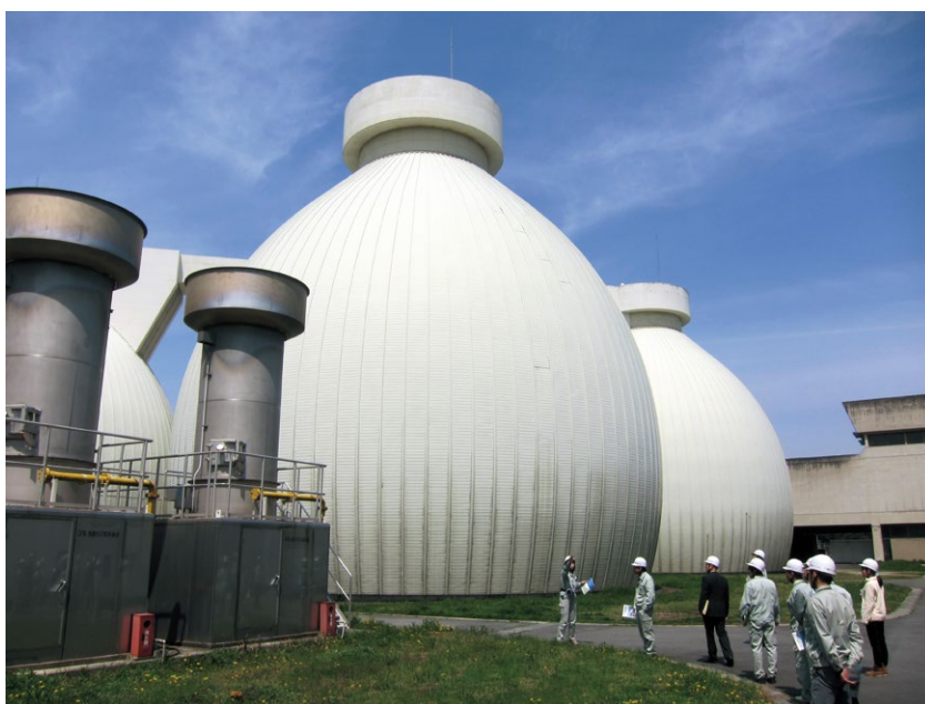
下水道施設における技術研修
