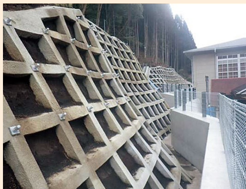
急傾斜地崩壊対策事業
