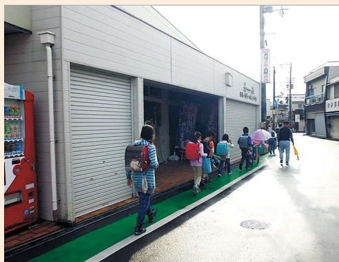
路肩のカラー舗装化
