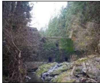
砂防設備(堰堤)
