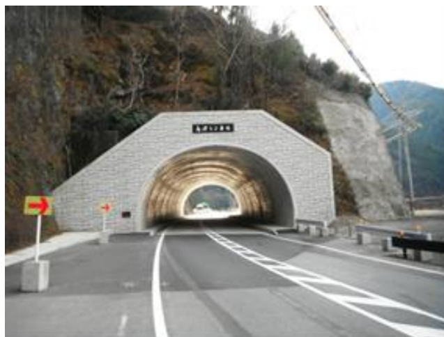
たこうつ 高津トンネル（平成 28 年 1 月）
