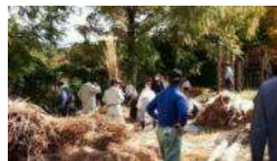
氷室の屋根の葺き替えの様子
