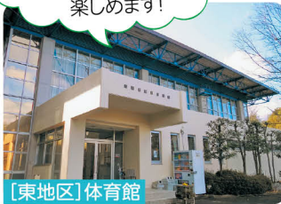
[東地区] 体育館
