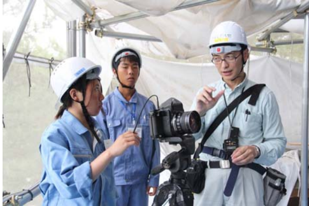
7/25 カメラ撮影研修、法隆寺中門修理現場
