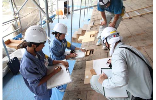
7/26 実測調査研修、法隆寺中門修理現場
