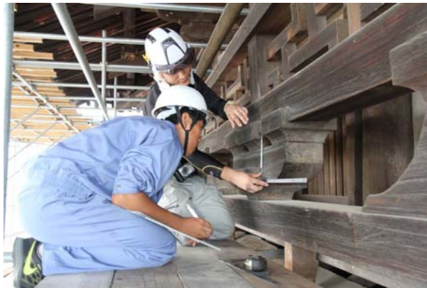
7/26 実測調査研修、法隆寺中門修理現場
