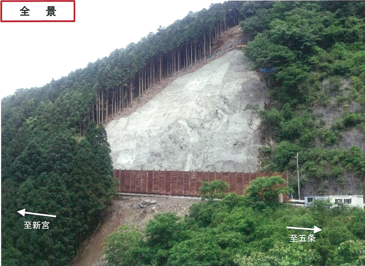
仮設防護柵設置状況
