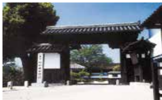
黒門（松山西口閘門）
