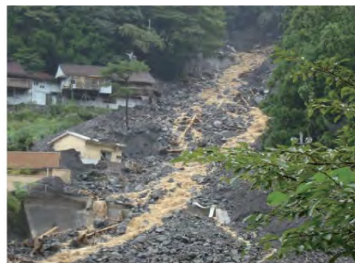
平成23年台風12号 土砂災害(五條市大塔町辻堂)
