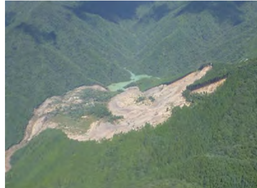
平成23年台風12号 河道閉塞(十津川村栗平)
