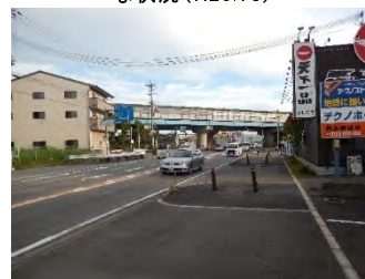
写真2 部分供用区間(H28.10)
