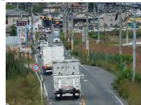
写真1 現道国道168号 (H28.10)
