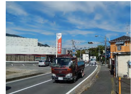
写真2 現道【2工区(現道拡幅区間)】 (H28.10)
