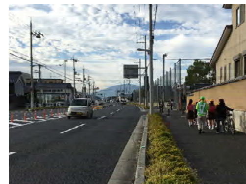
写真1 部分供用区間(H28.10)
