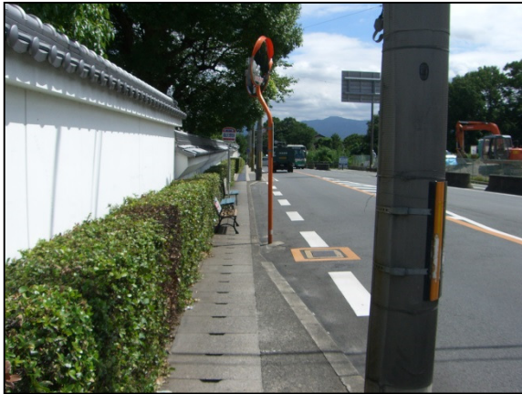
写真：現道における電柱の現状
