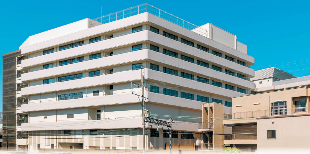
県立医科大学附属病院E棟
