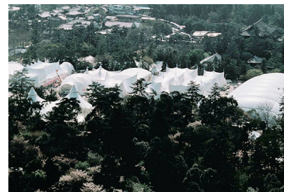
◆布（テント）を使用した仮設建物：なら・シルクロード博（1988）太陽工業（株）HP
