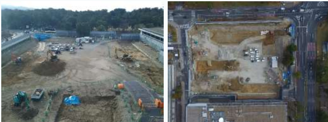
工事状況(平成28年12月2日現在)
