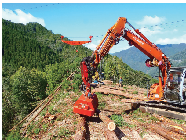
架線と高性能林業機械の組み合わせによる集材(十津川村)
