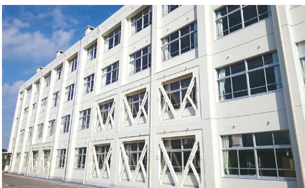
耐震改修工事(奈良県立平城高校)
