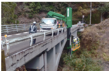
橋りょう点検(十津川村)
