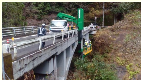
道路橋梁の点検
