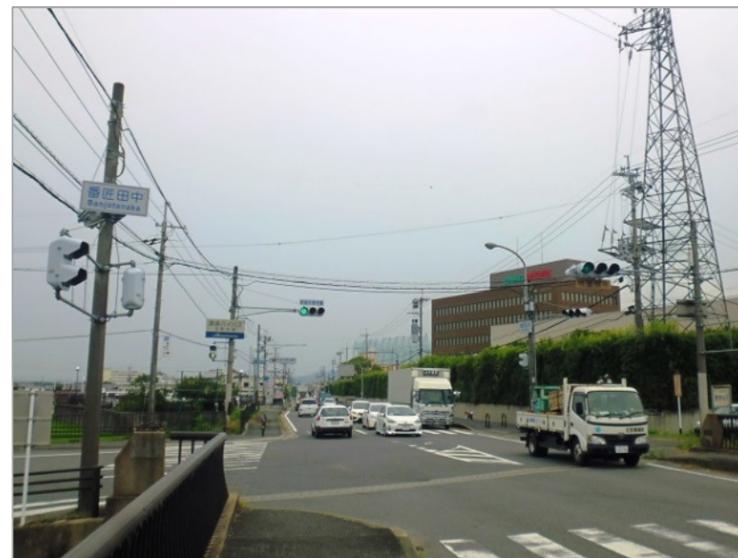
県道木津横田線(奈良事業所付近、現状)
