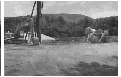
写真：建替工事中 昭和61年撮影 出典イ
