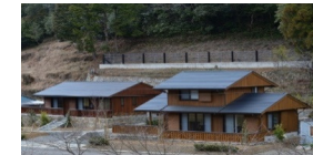
【十津川村復興住宅】
