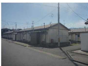
建替予定の老朽化した団地
