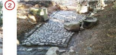
写真②建造物に関する遺構を確認しました。石張りは漆喰で固定されています。
