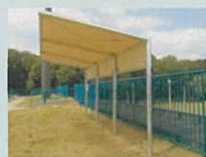
アルプスの日よけ設置
