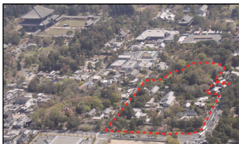
当該地（赤枠）の状況（平成26年）
