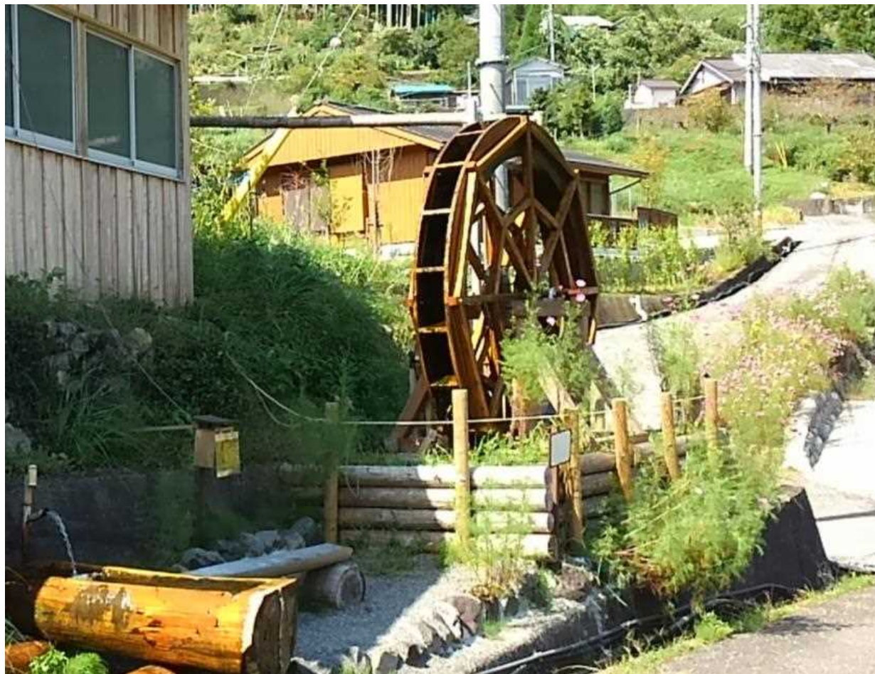
十津川村谷瀬地区の小水力発電水車
