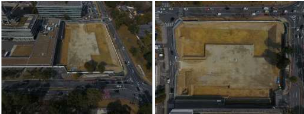
工事状況(平成29年2月末)
