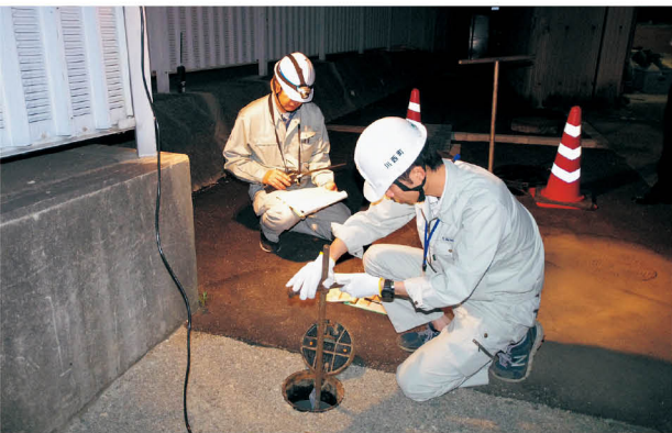
川西町 平成29年6月の直結配水切替作業のようす
