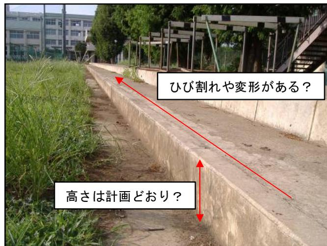
③放流施設の異常（堆積土砂、構造物の破損、放流孔（オリフィス）の閉塞など）の有無を確認する。
