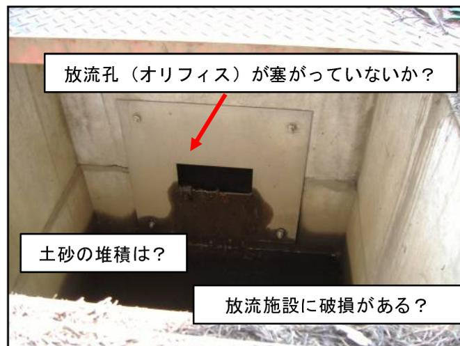
④グランド表面の異常（堆積土砂による隆起、平坦性など）を目視により確認し、異常が見受けられる場合は測量を行い、計画貯留量が確保されているか、また、どれだけ貯留量が不足しているか確認する。
