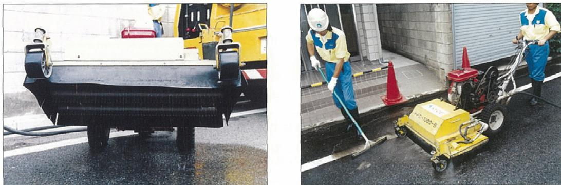
図 1.6 透水性舗装高圧洗浄機、清掃状況
