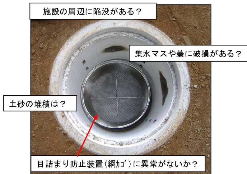
⑥側溝外見の異常（破損、蓋のずれ、周囲の陥没など）の有無を確認する。
