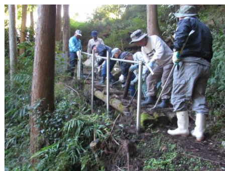
▲木製スロープ撤去作業
