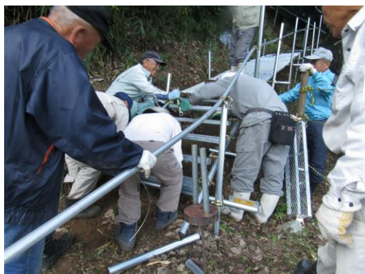
▲金属スロープ・階段作成
