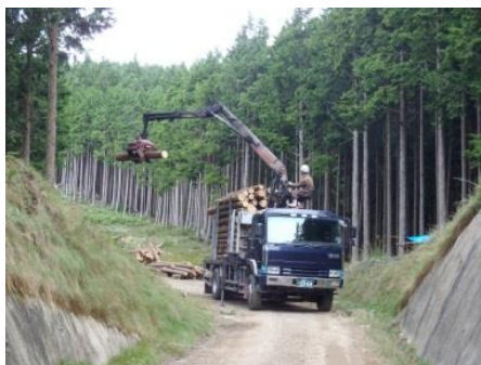
グラブ付トラックによる木材の積込
